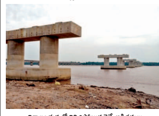
నిర్మాణం మధ్యలో నిలిచిపోయిన రైల్వే బ్రిడ్జి వసులు
